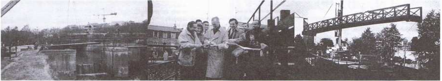
1991 montage puis inauguration de la passerelle du déversoir (26 octobre)
